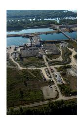
La centrale hydroélectrique EDF de Gerstheim est dotée d'une passe à poissons depuis 2019, reprise sur le mode innovant de celle de Strasbourg. Elle permettra la remontée des poissons et notamment du saumon vers la Suisse, conformément aux engagements pris par l'Etat français dans le cadre du programme européen Rhin 2020.
